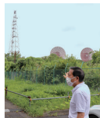
返還された米軍通信施設跡地の電波塔を視察
