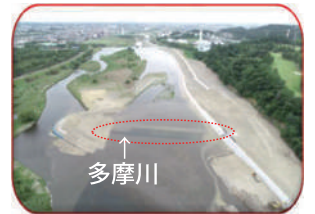
右岸側の帯工等の整備状況 (令和5年4月撮影)
