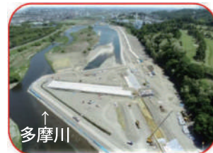
帯工・取水施設等の施行状況 (令和5年4月撮影)
