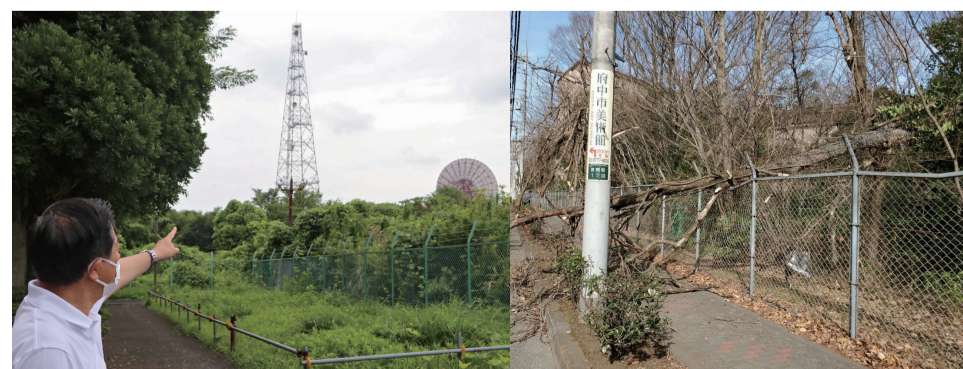
(左) 鉄塔と巨大なパラボラアンテナが未だに残されている。 (右) 過去には敷地内の木が隣接道路に倒れることもあり、安全管理も求められる。
